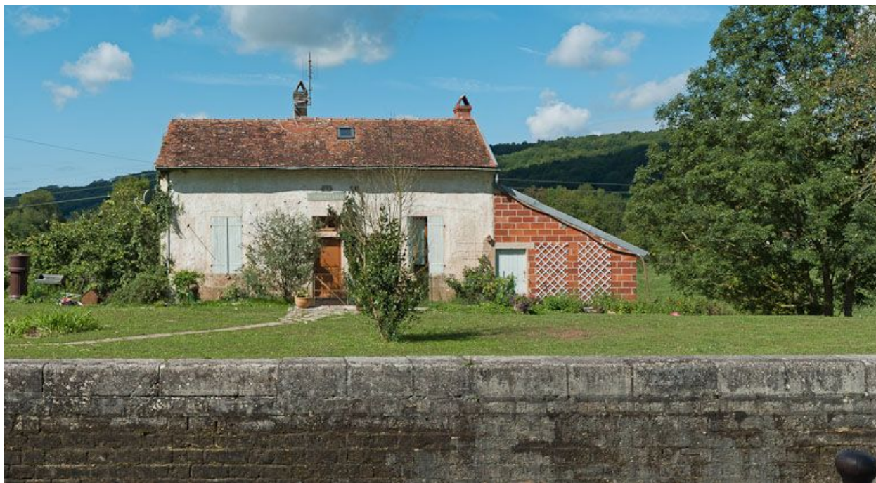
Vue de face de la maison éclusière.
