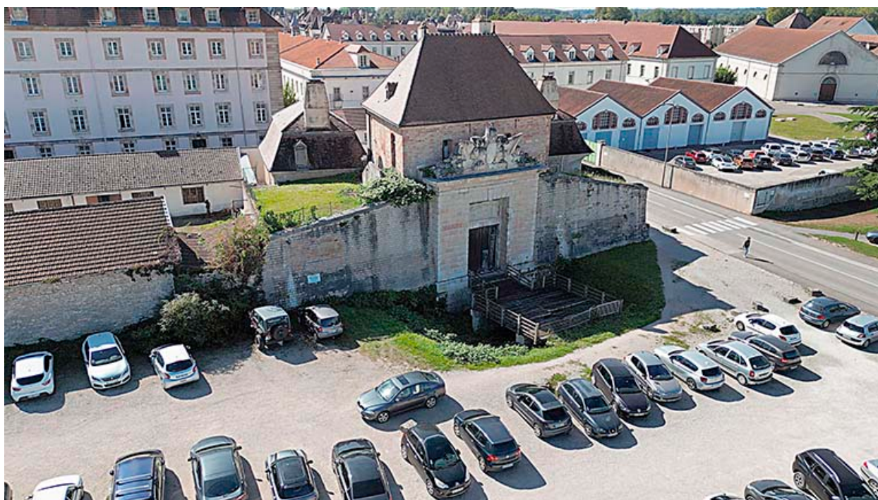
Vue aérienne de la porte.
