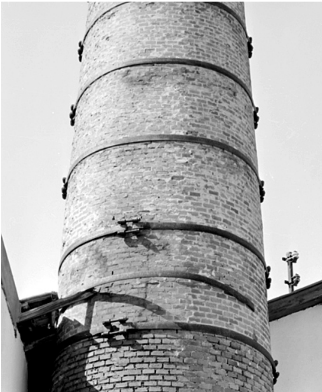
Détail de la cheminée : cerclages métalliques.
