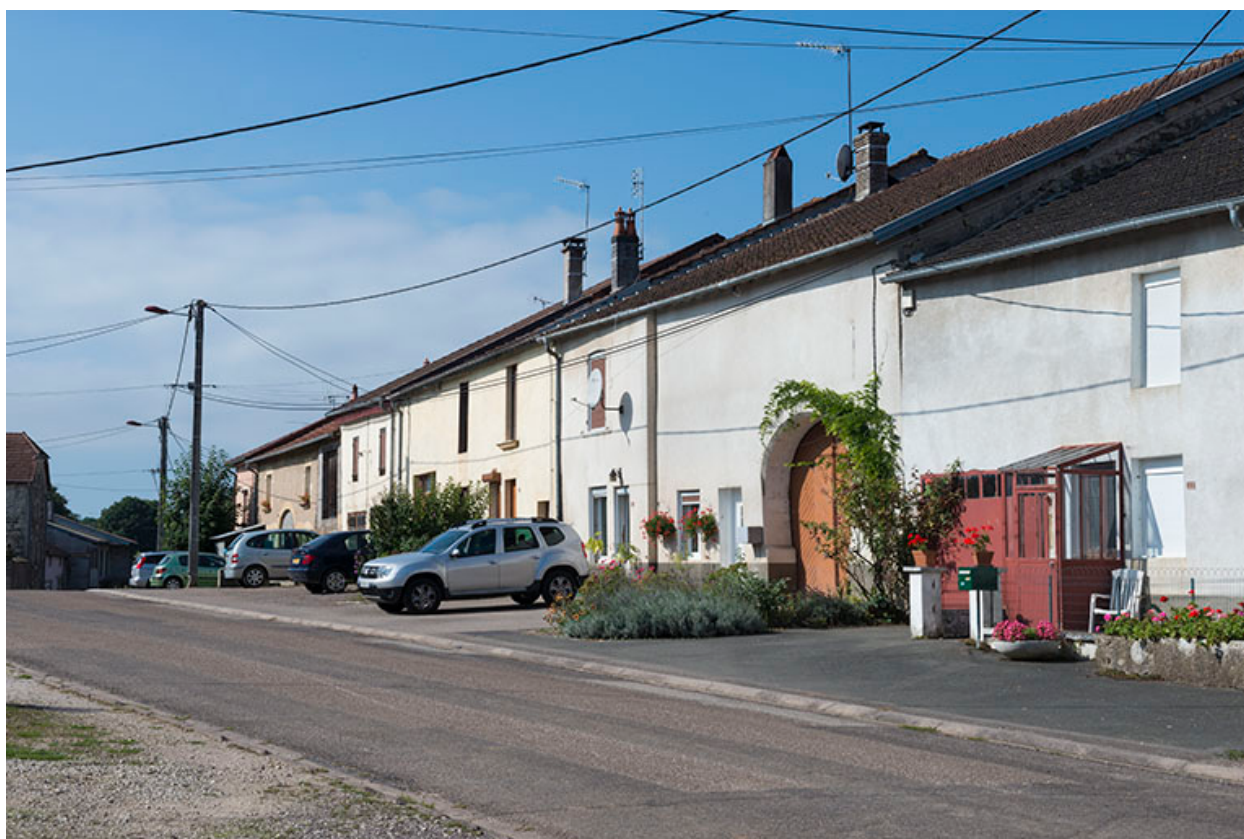
Vue générale, Grande rue.
