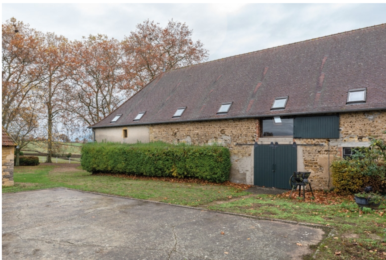
Façade antérieure de la grange
