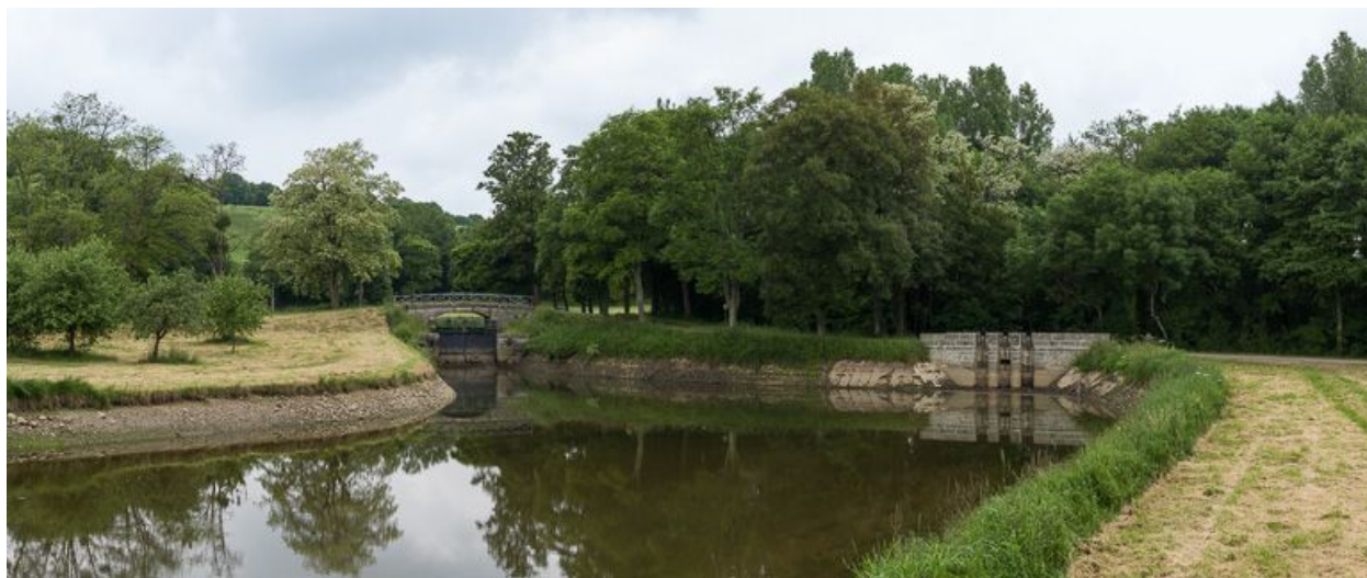
Ecluse de garde sur la rive droite du canal et déversoir de fond.
