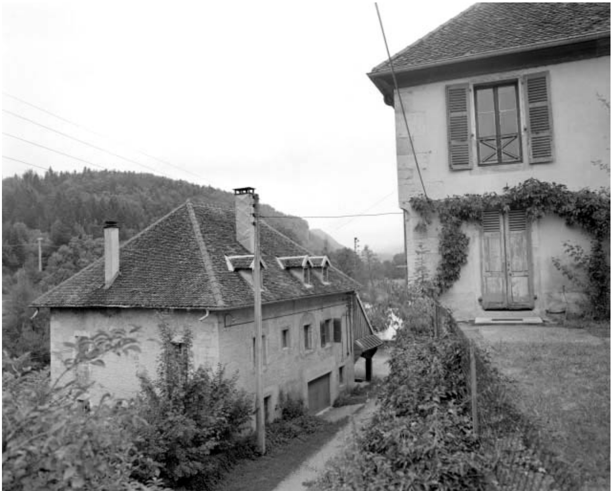
Moulin : façades antérieure et latérale droite.
