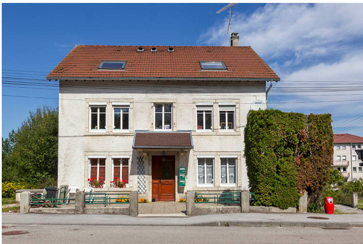
Logement patronal : façade antérieure.
