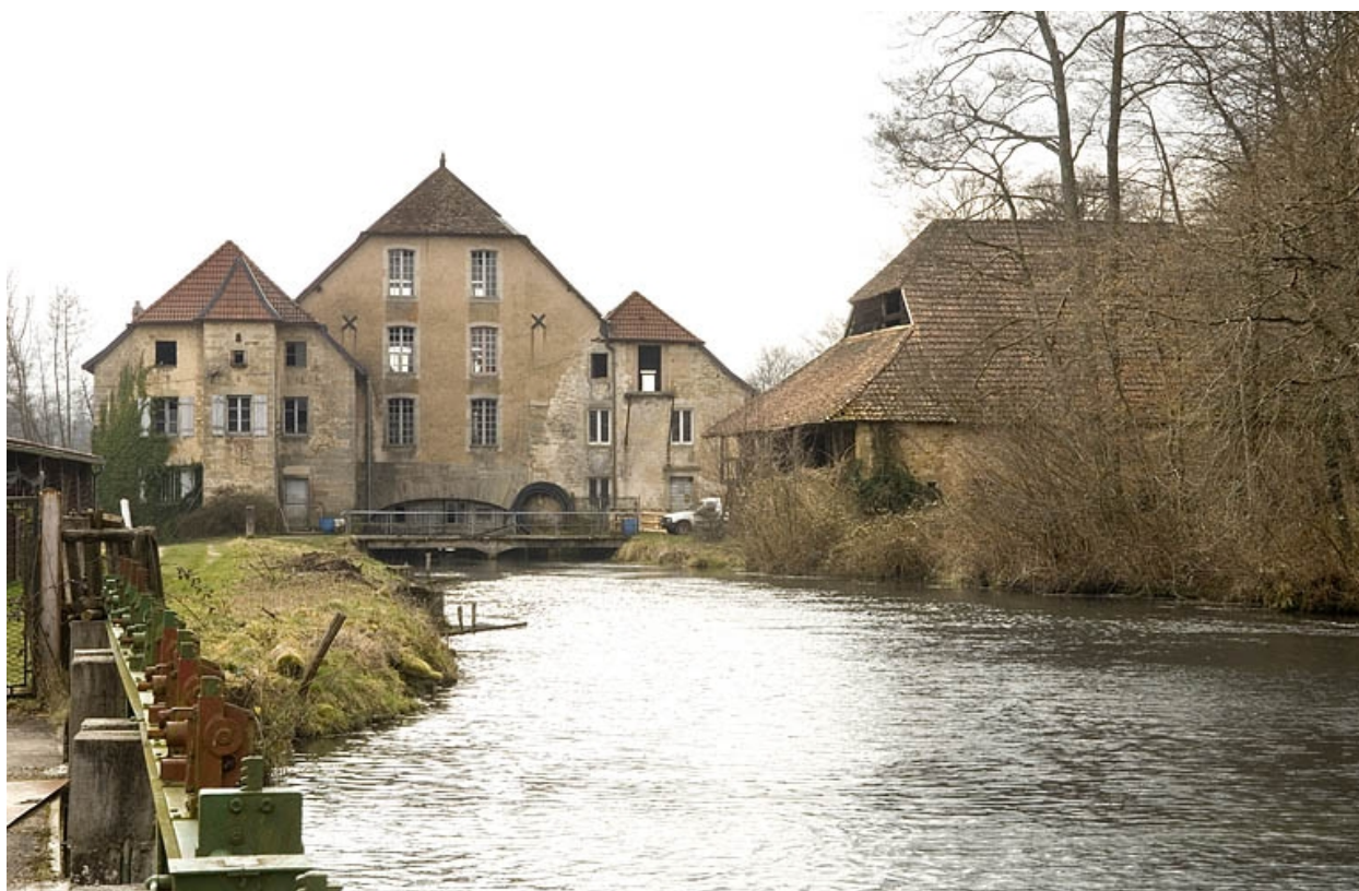
Vue d'ensemble depuis l'amont.
