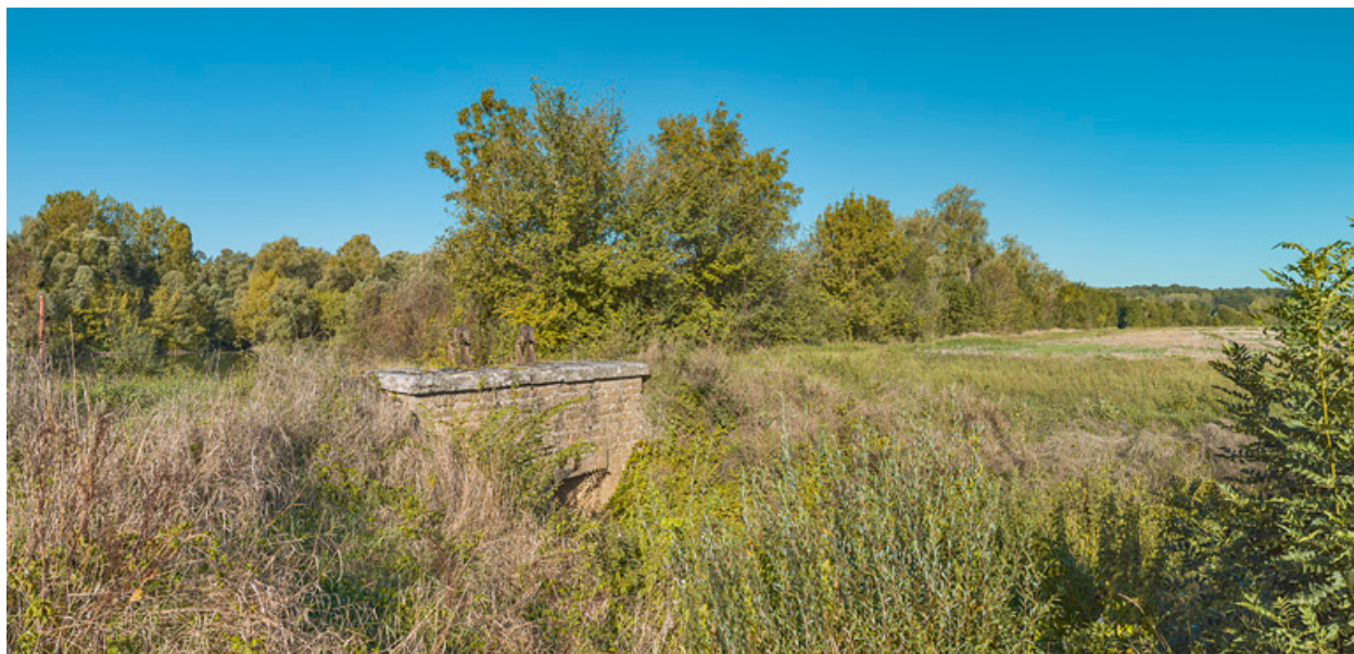
Le ponceau dans son environnement.
