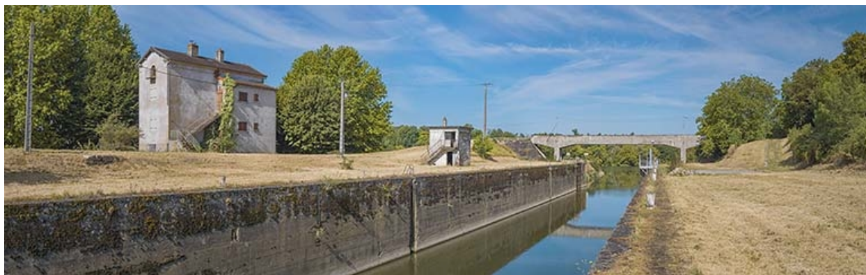
Le sas de l'ancienne écluse.
