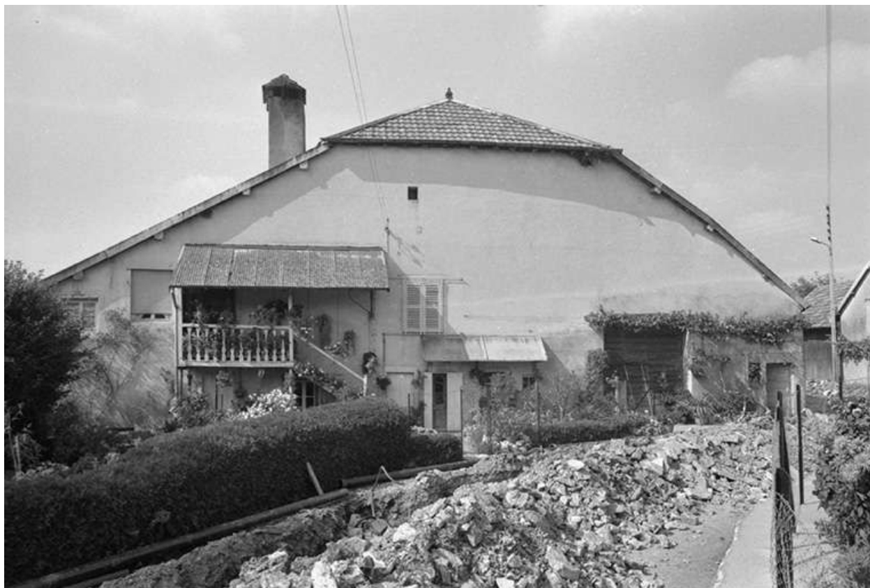
Ferme située route de Naglans.
