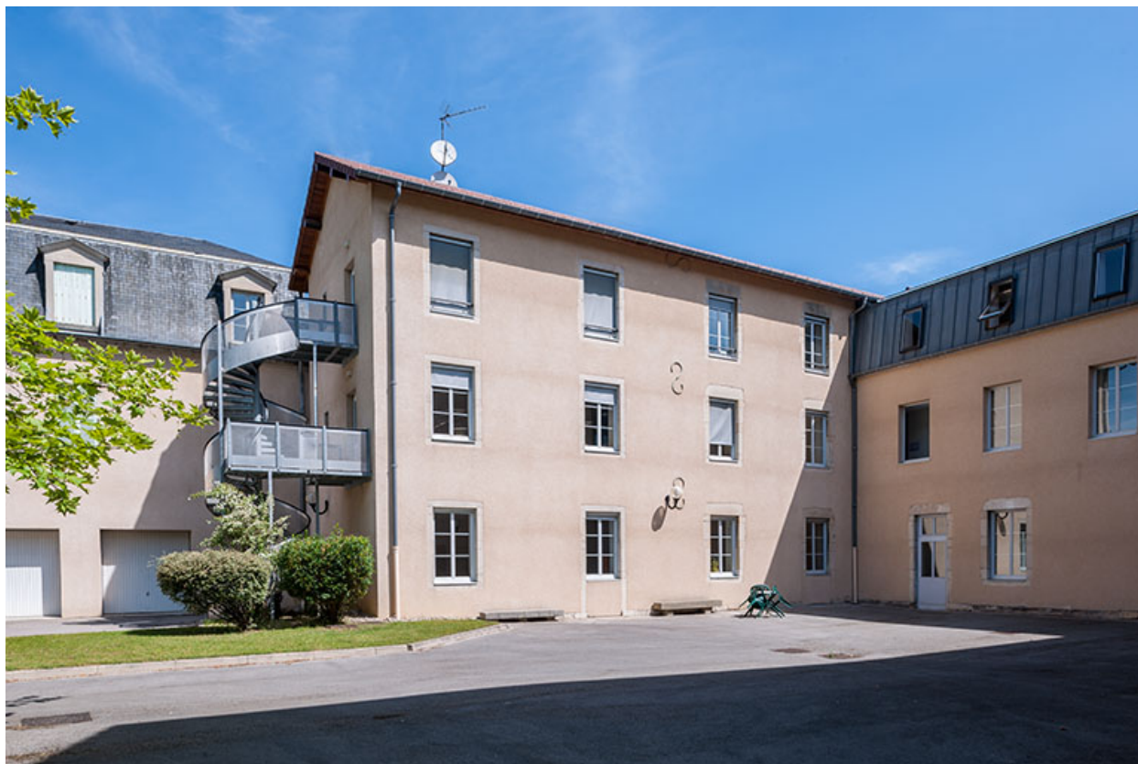
Façades postérieures des bâtiments administration.
