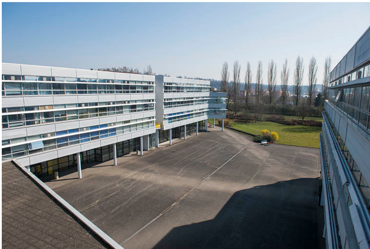
Cour vue de l'externat.
