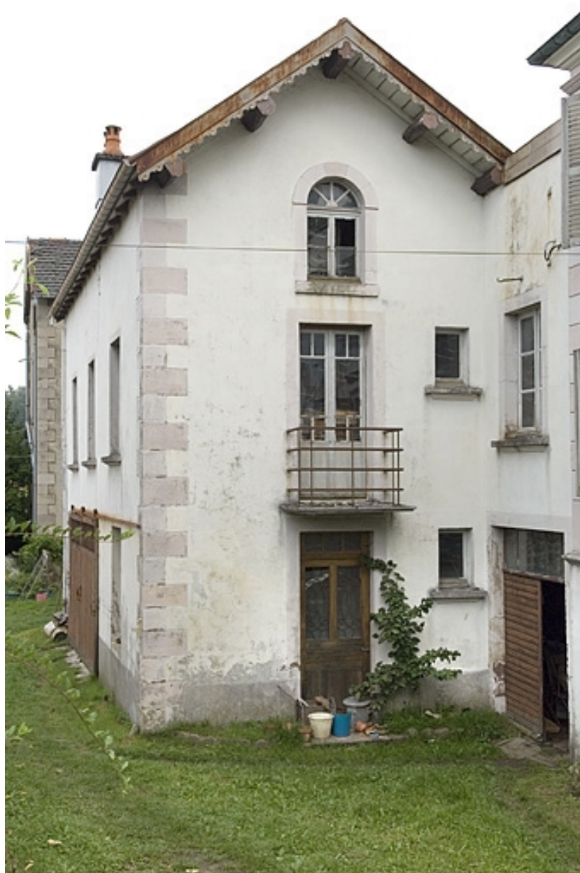
Garage, écurie et logement. Pignon du bâtiment.
