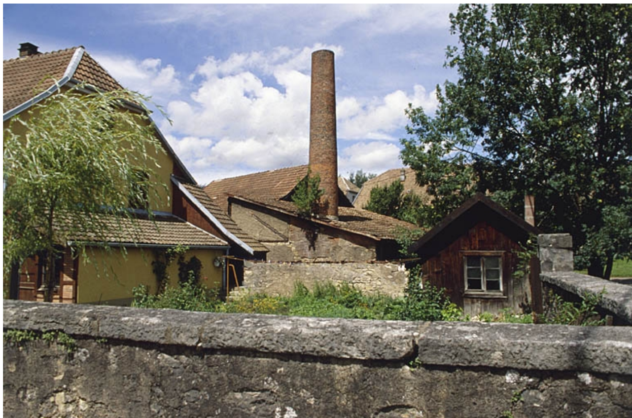
Vue en amont de la Batte.
