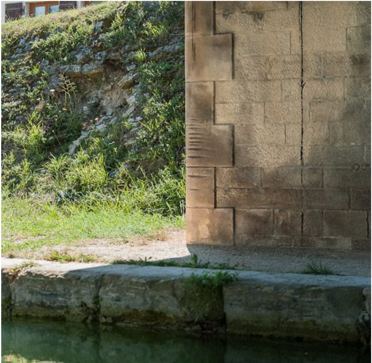
Détail des marques de halage sur la pile du pont.
