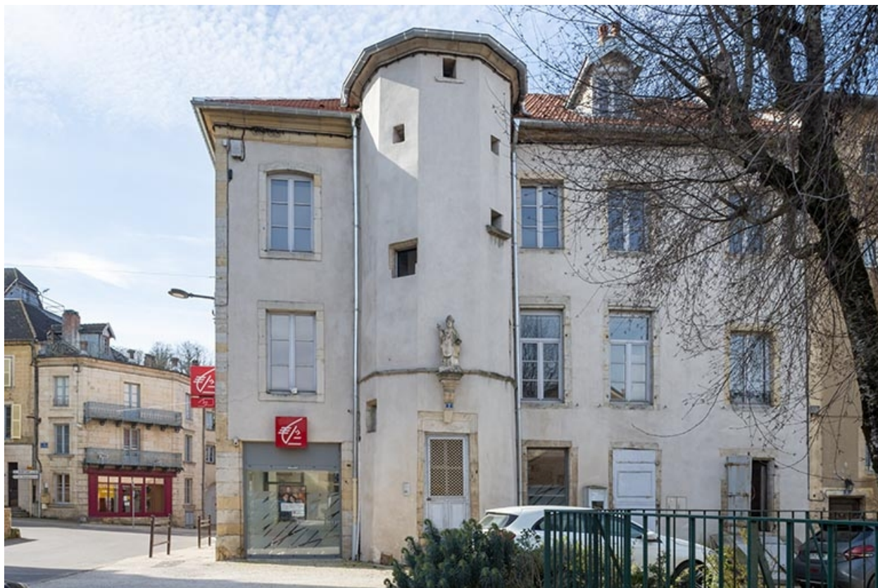
Façade orientale de la maison.
