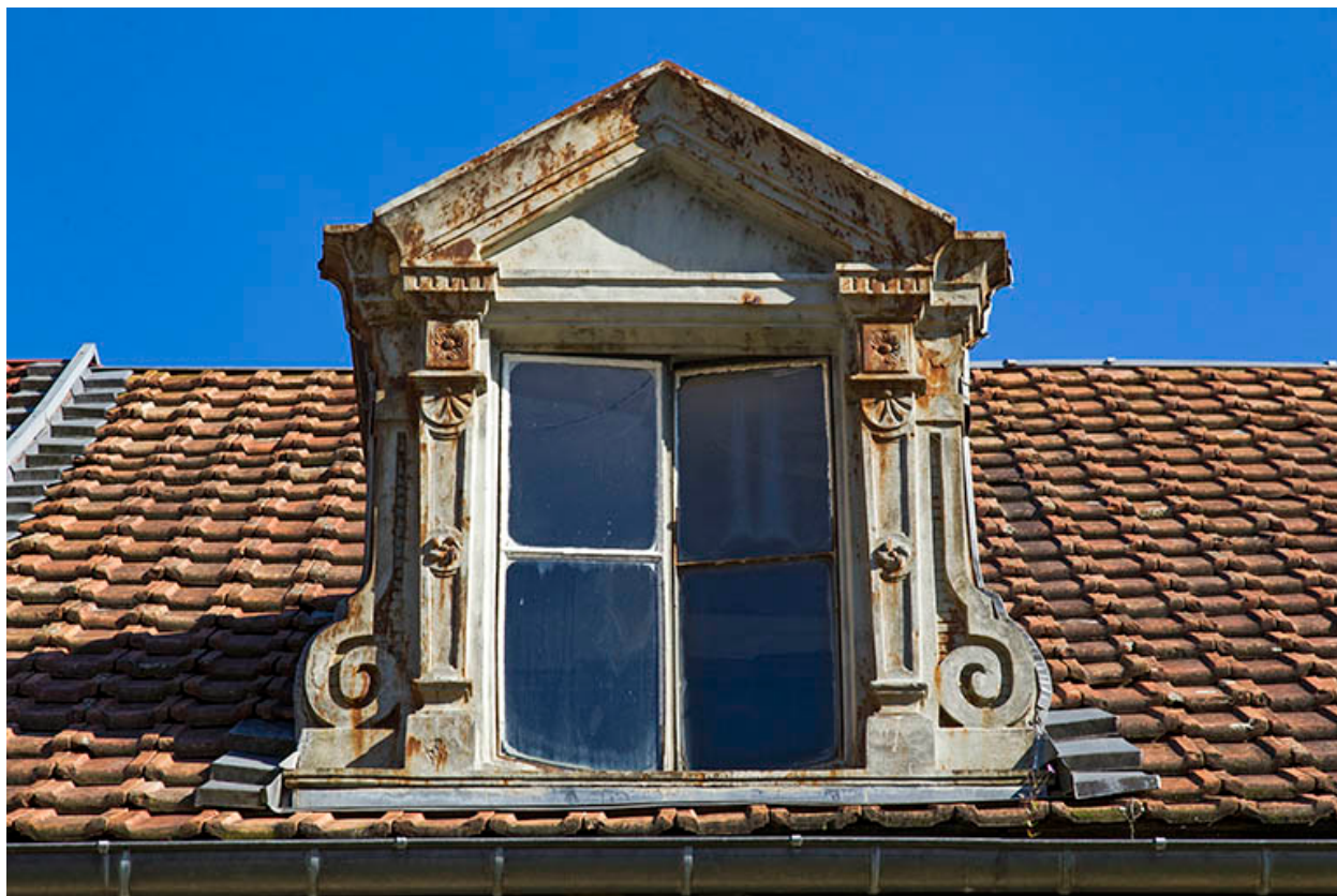
Corps sud, façade antérieure : lucarne.
