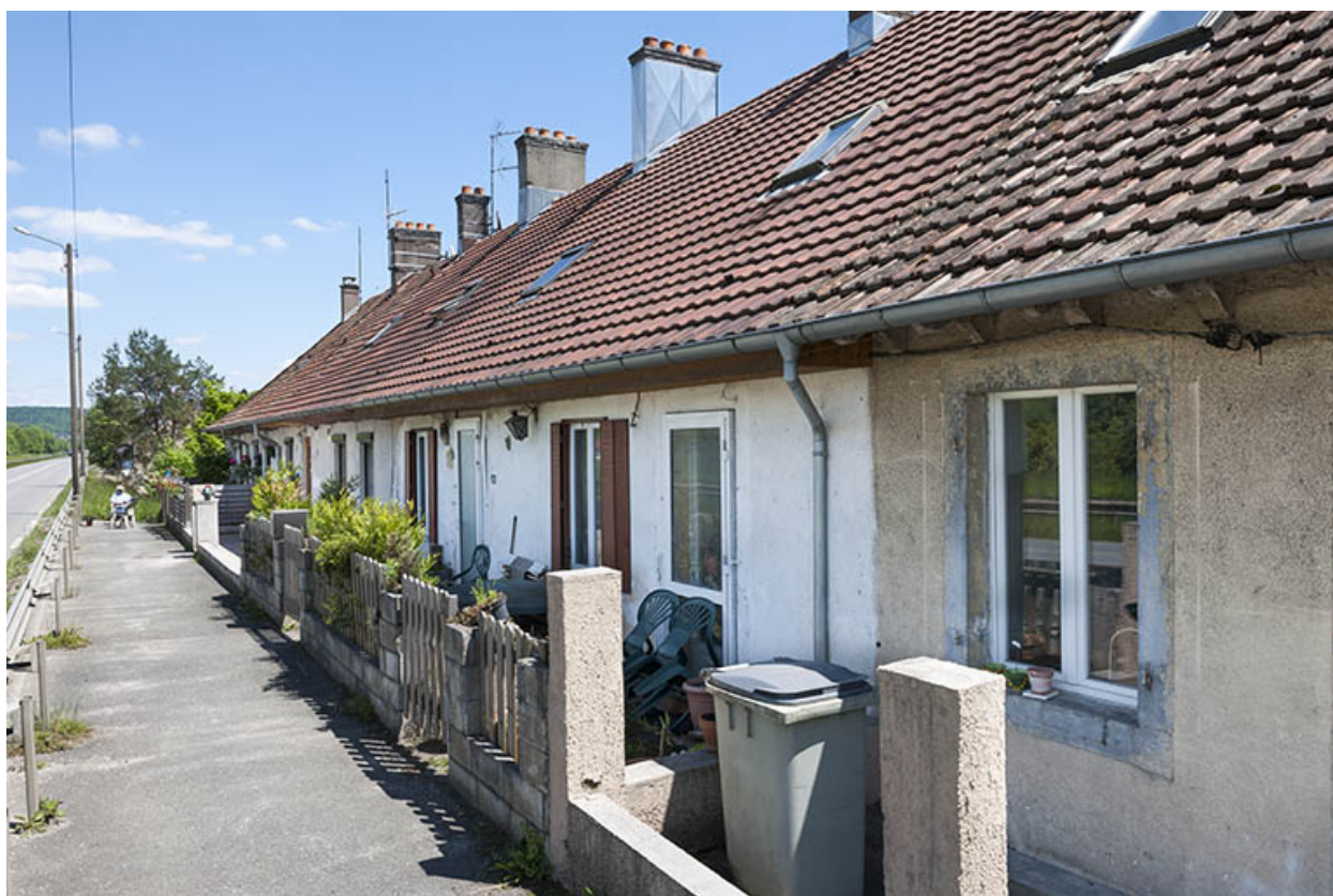
Façade nord d'une habitation de type caserne.
