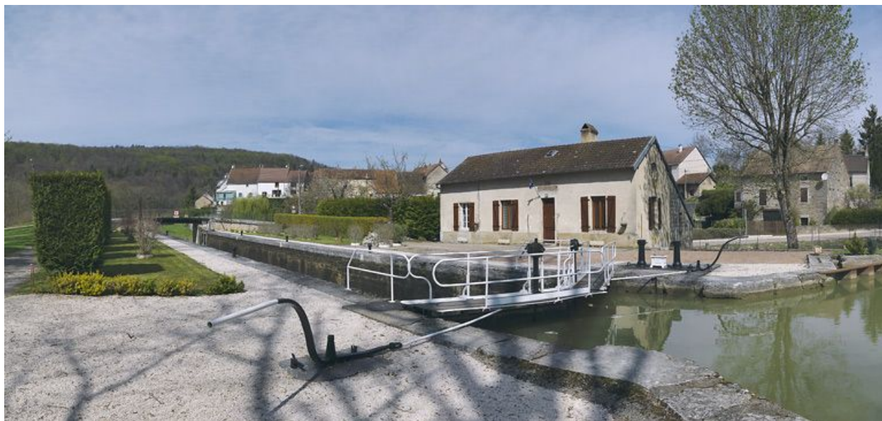
Vue d'ensemble de l'amont du site d'écluse.
