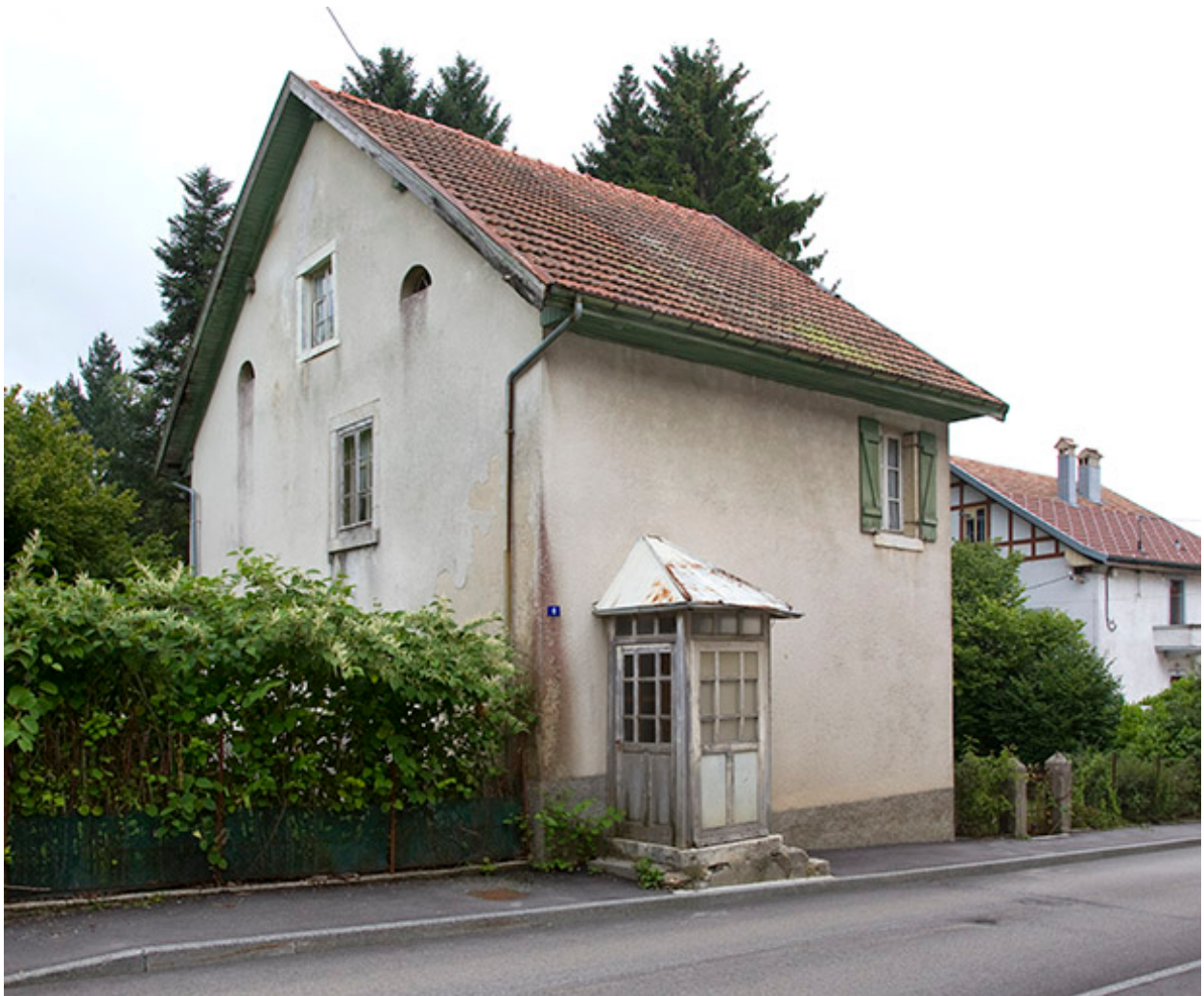
Façades antérieure et latérale gauche.
