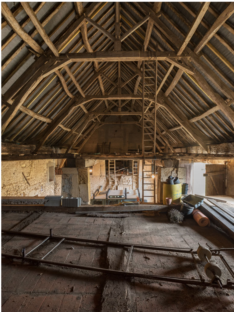
Charpente de la grange, construite en 1831.
