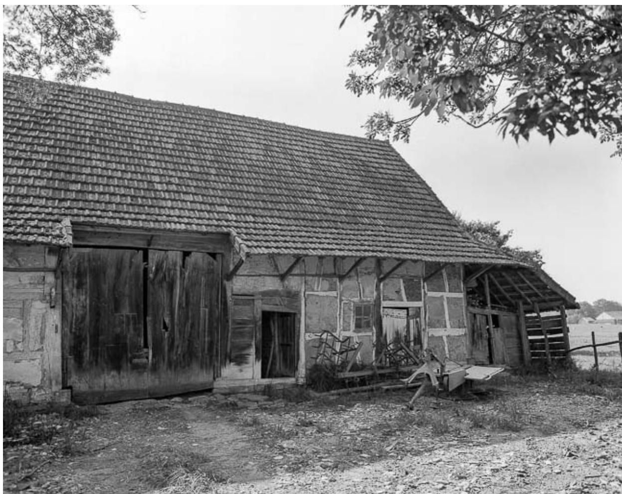
Façade antérieure : partie droite.
