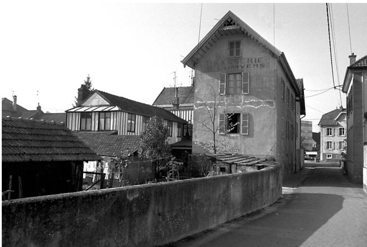
Audincourt : maison située 17 rue Neuve.
