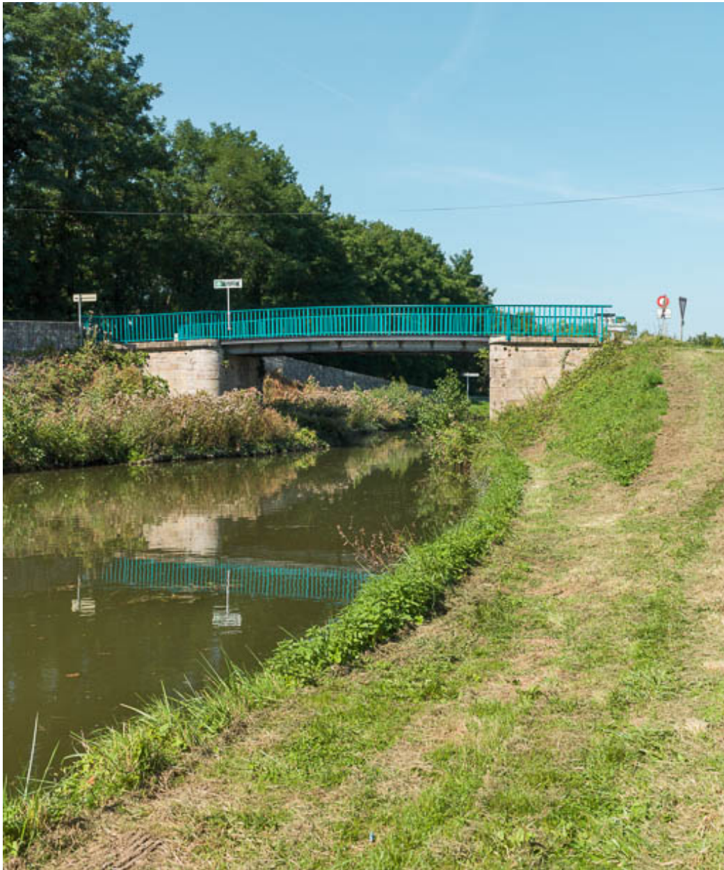
Vue d'ensemble du pont.
