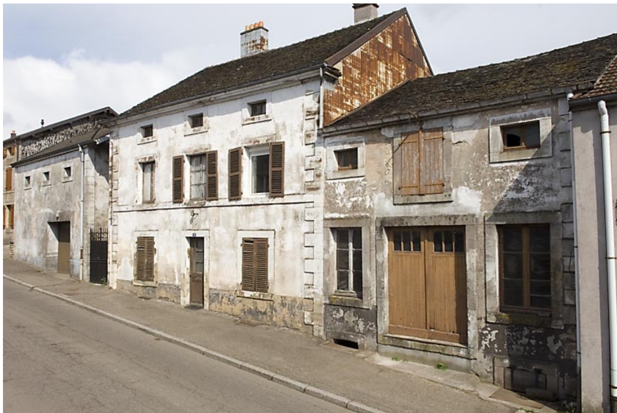
Vue d'ensemble depuis la rue de Plombières.
