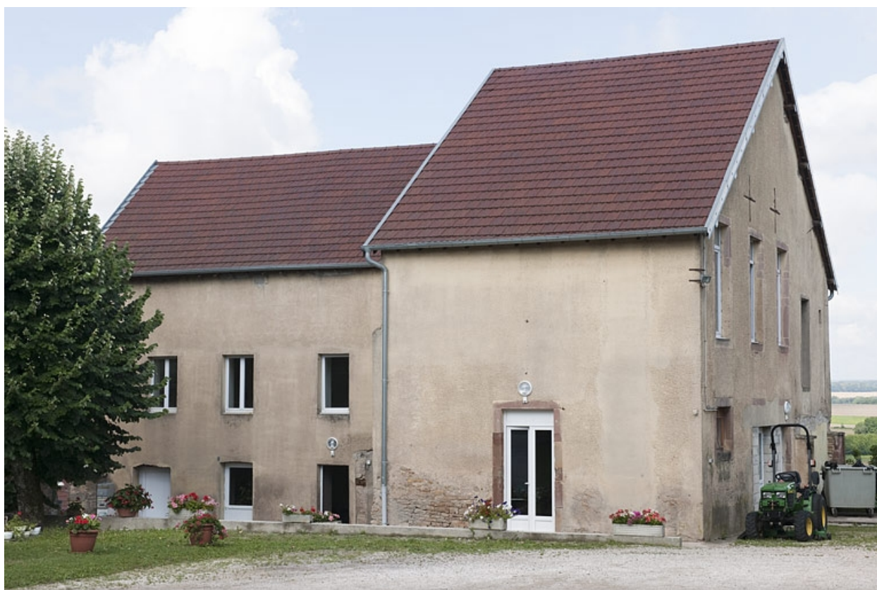
Bâtiment (B), vue d'ensemble depuis la cour.
