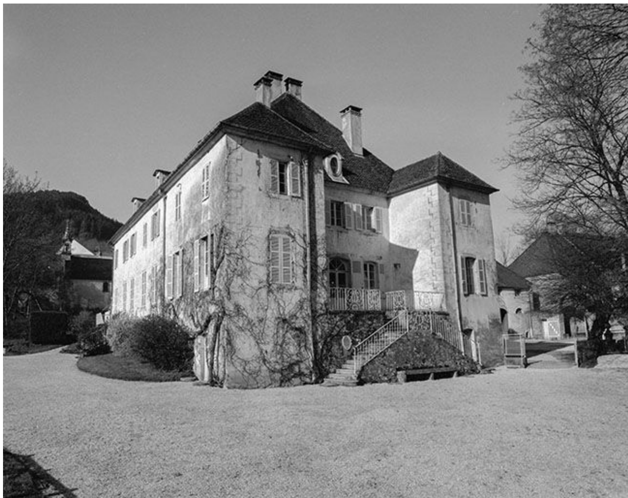
Logis : façade nord.
