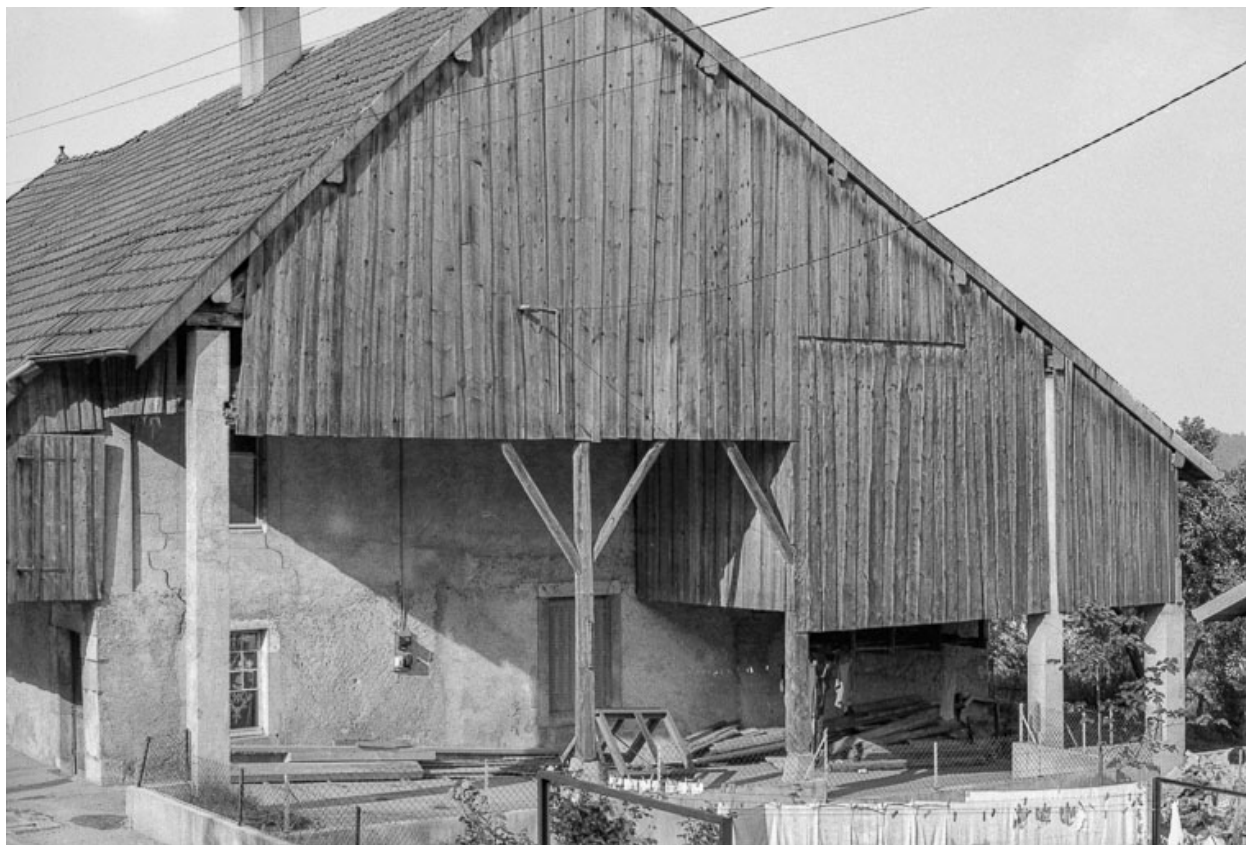
Ferme cadastrée 1962 E 189 : façade latérale droite.
