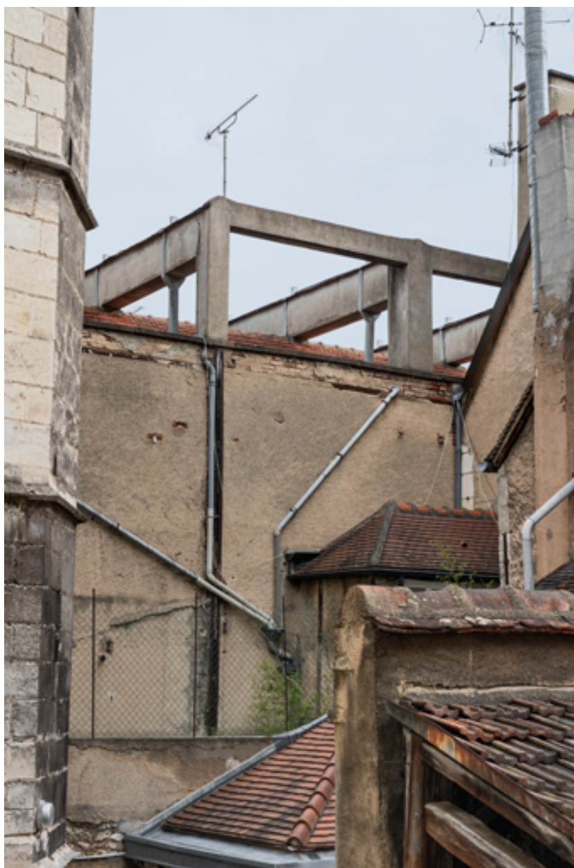
Façade latérale gauche et portiques en béton.
