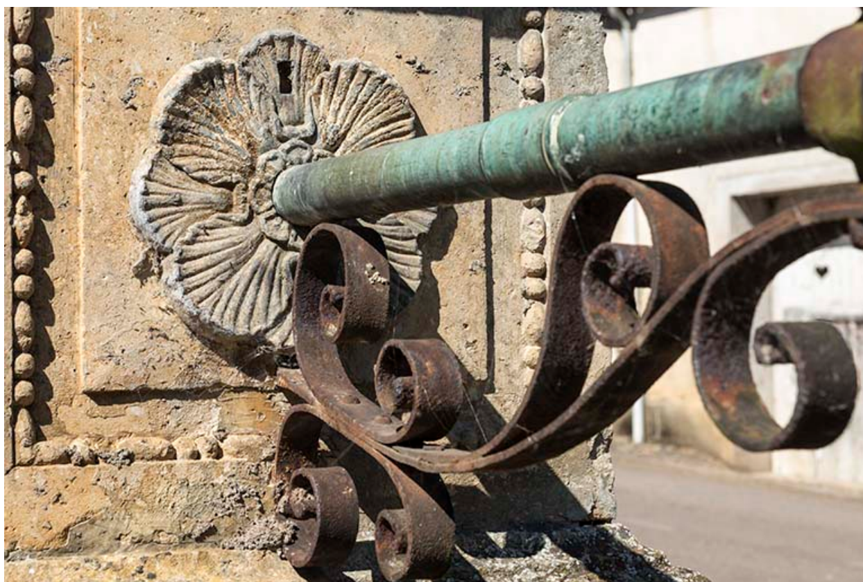
Détail du jet en fonte.
