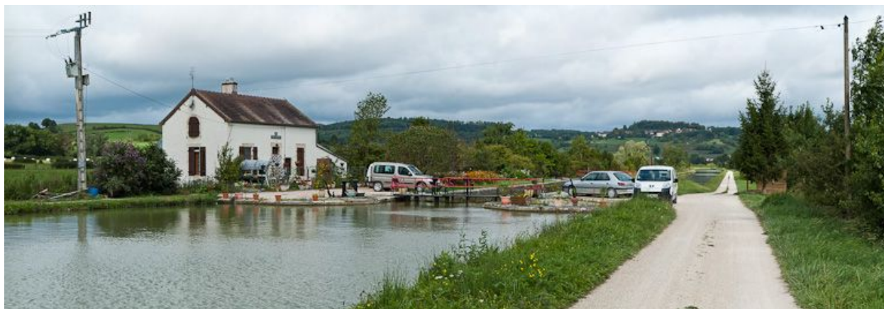
Vue du site d'écluse depuis l'amont.
