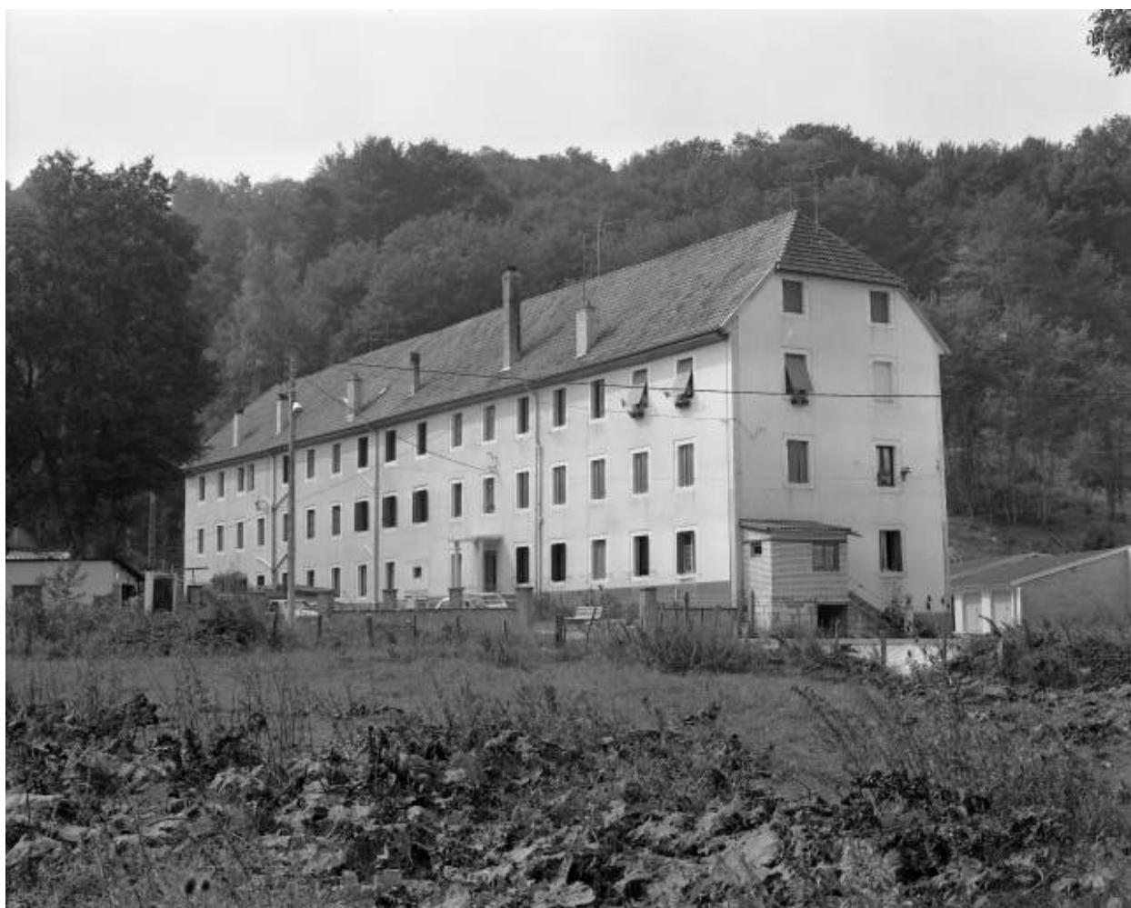
Vue d'ensemble depuis le sud-est en 1981.
