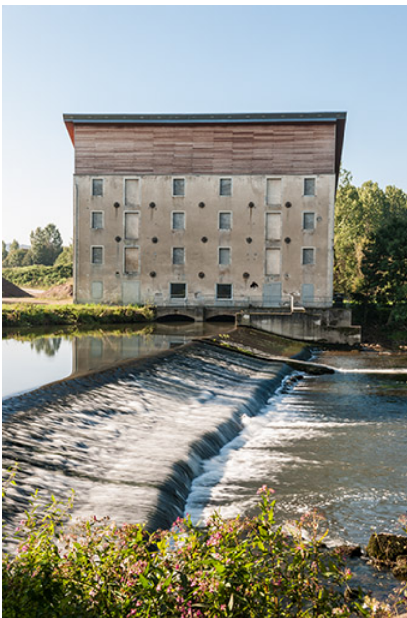
Façade nord depuis l'extrémité du barrage.
