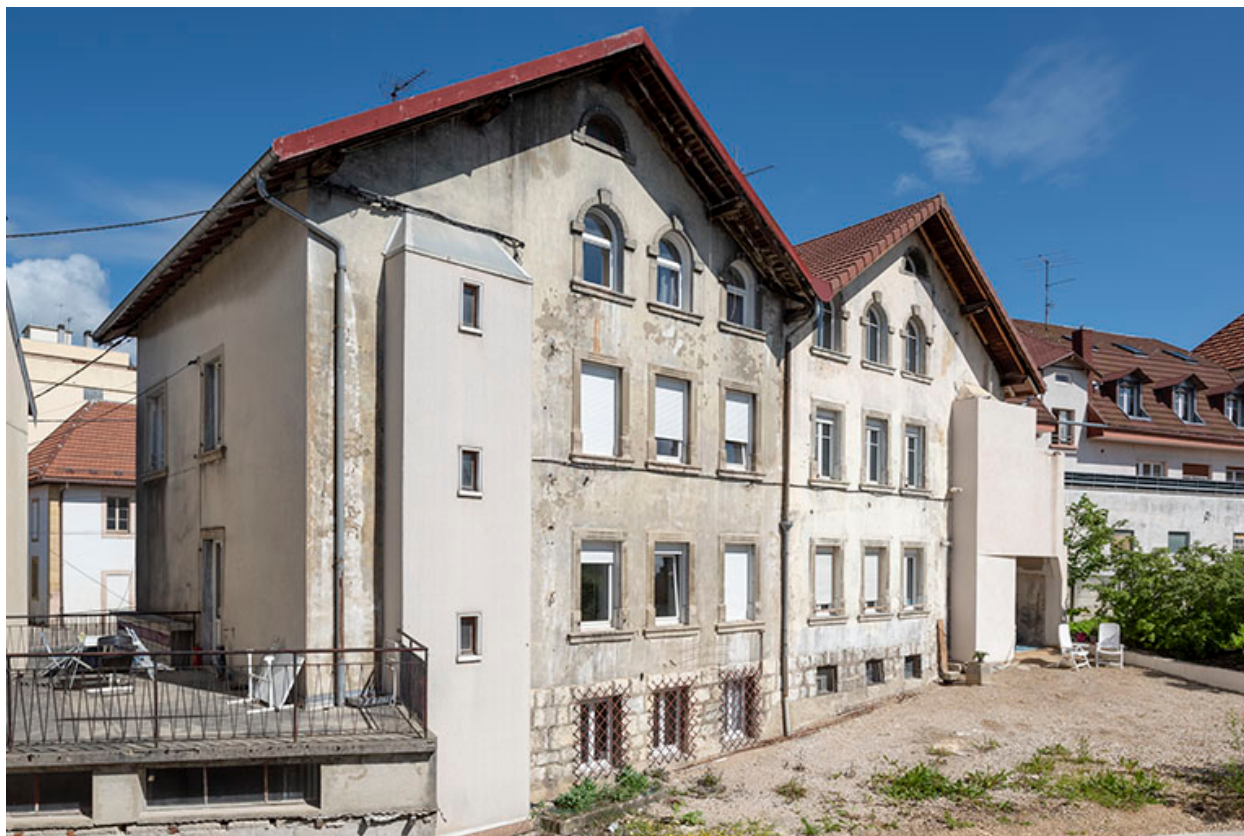
Façades postérieures, de trois quarts gauche.
