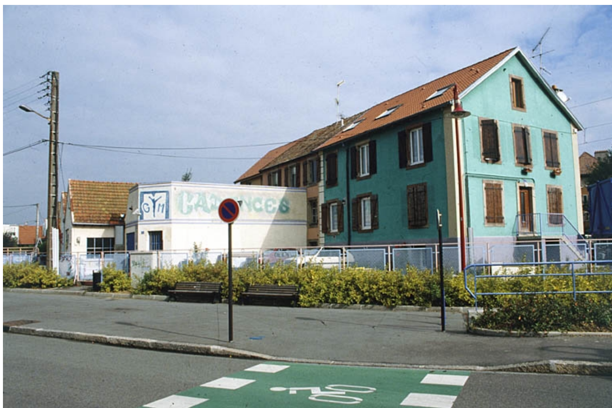
Ateliers et logements depuis le sud.
