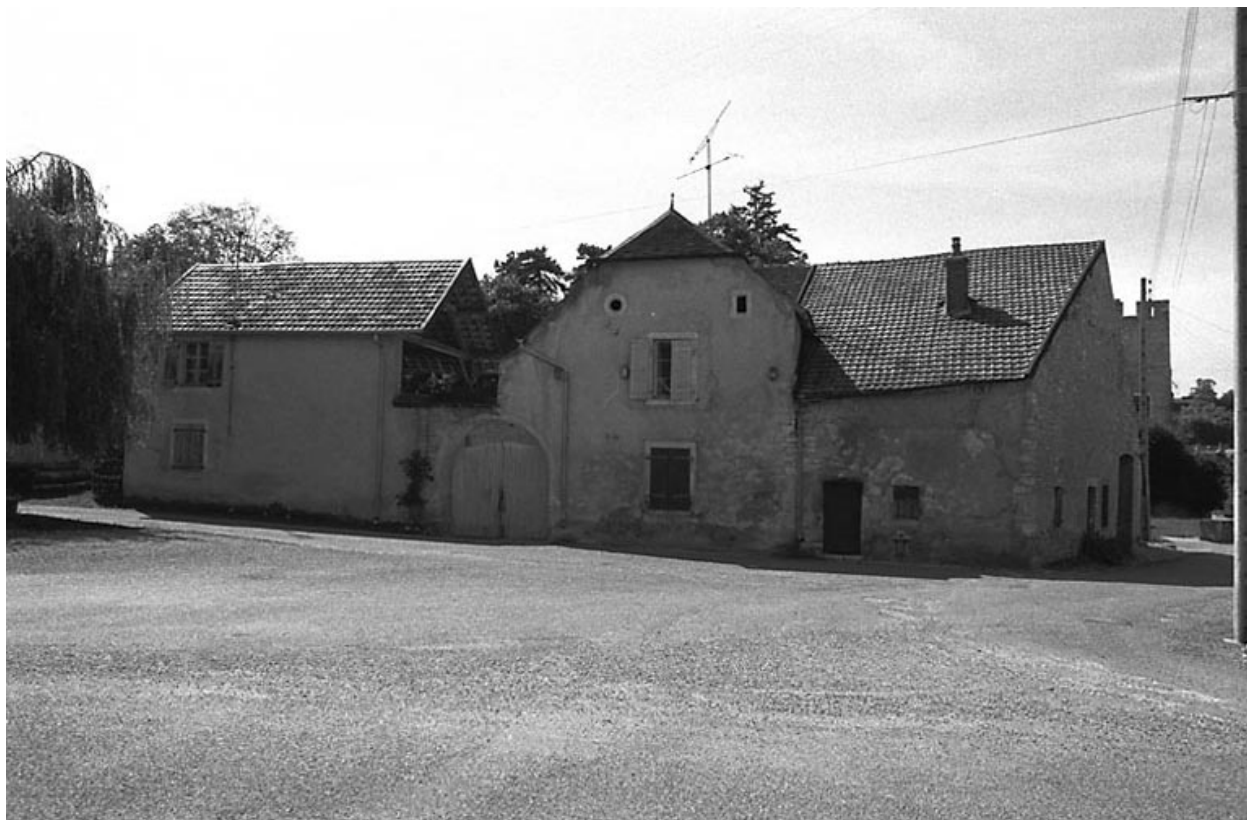
Ferme située rue de Barrey
