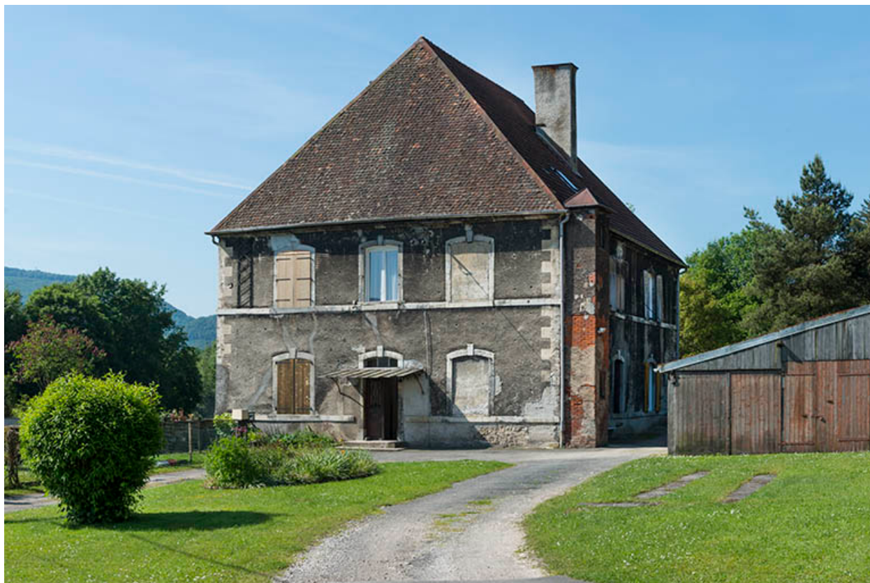
Façade nord du logement patronal.
