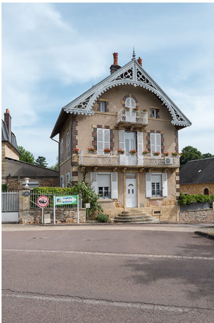
Façade principale sur l'avenue Eugène Collin.
