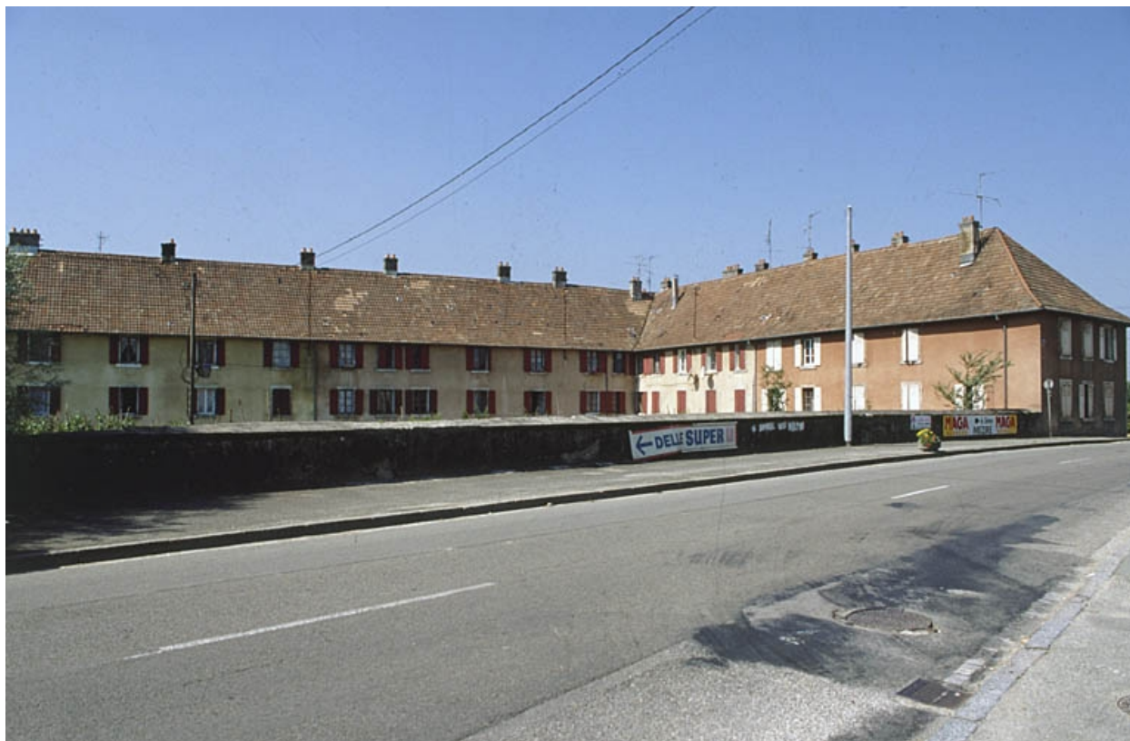
Logement ouvrier dit la Caserne depuis l'est.
