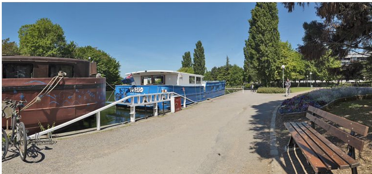
Vannes du déversoir de fond du port.
