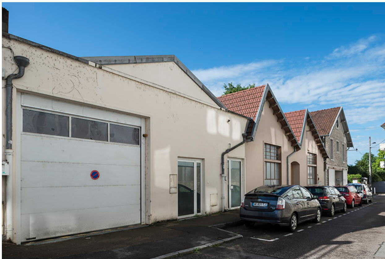
Façades postérieures (rue Klein).
