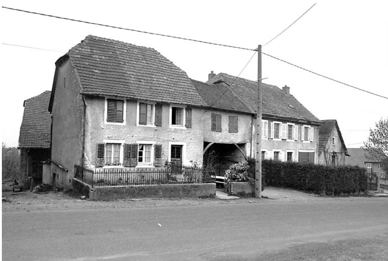
5e ferme : vue d'ensemble.
