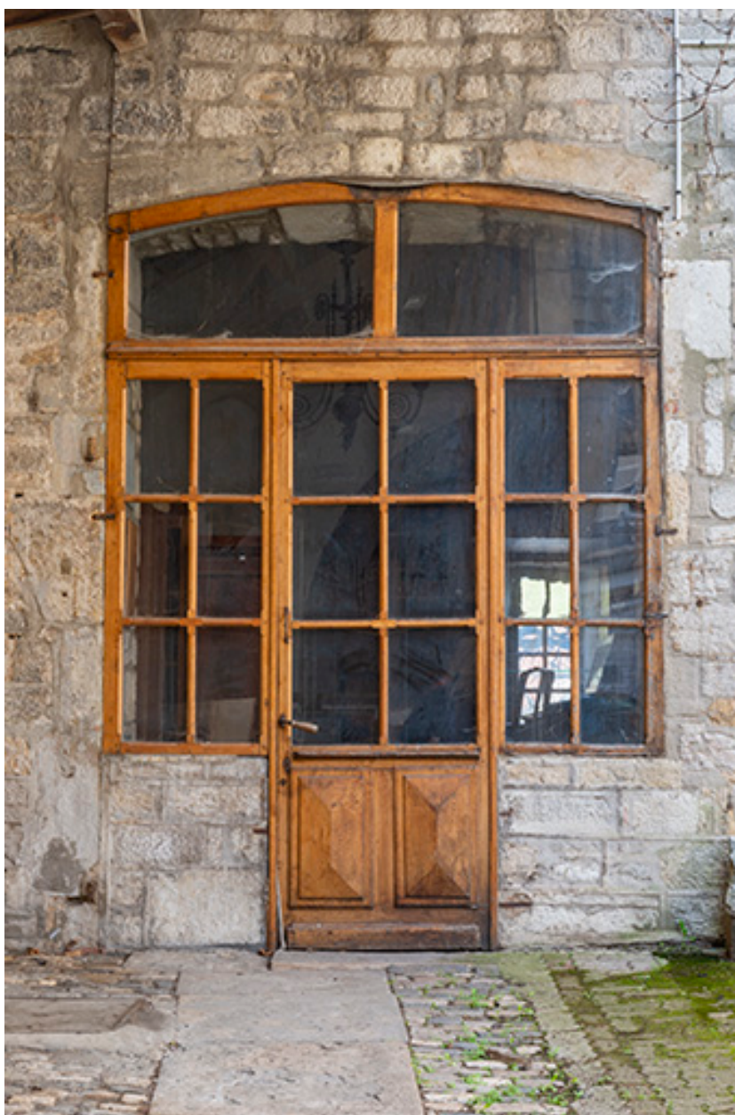
Porte gauche sur cour (mur est).
