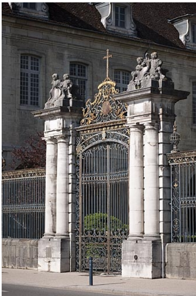
Le portail d'entrée de la cour.
