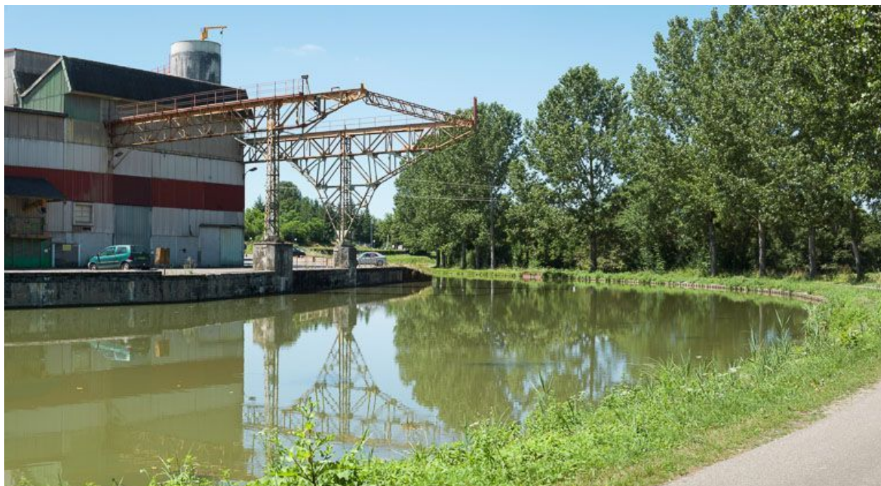
Le pont de chargement.
