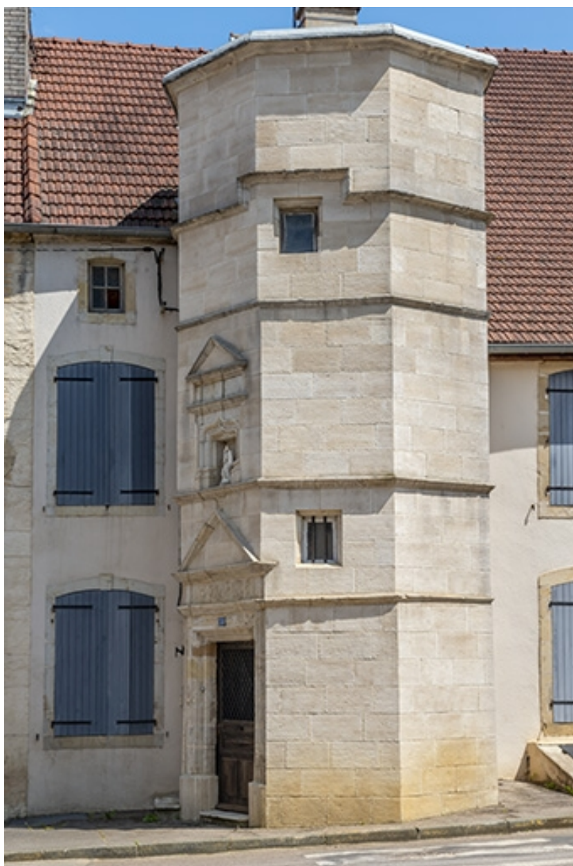
Vue rapprochée de la tour d'escalier.
