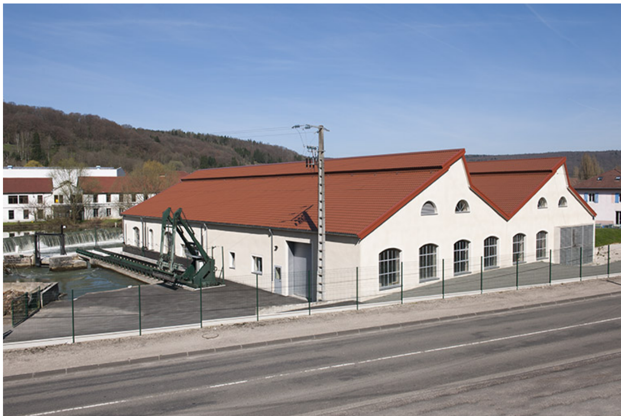
La centrale hydroélectrique vue de trois quarts.
