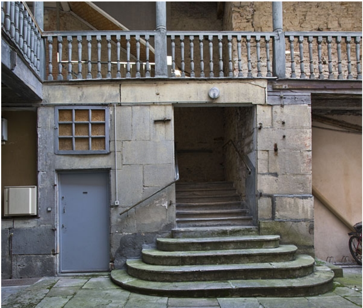
Escalier extérieur : détail du départ de l'escalier.
